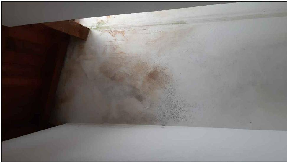
foto 11 - vista della parete sottostante la copertura del vano scala interno con le macchie di umidità da infiltrazione.
